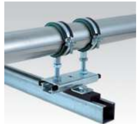
Монтаж скользящего «башмака» и скользящей опоры, «стоя» на МРС-Профиле
