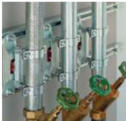
Виброизоляция опор водопроводов
